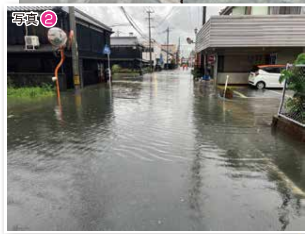
道路冠水(災除川付近)
