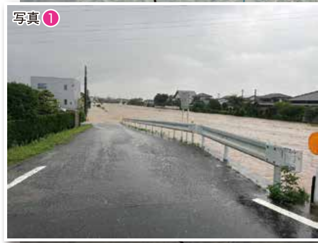
河川氾濫(巨瀬川・かっぱ橋付近)
