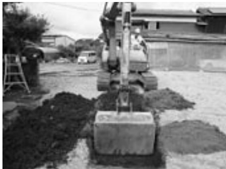
▲ショベルカーによる試掘調査風景
