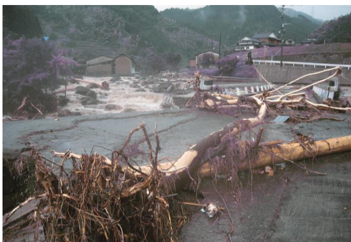
▲ 土砂災害で道路寸断
