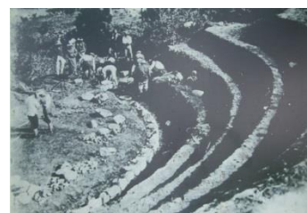
▲「円形劇場」の建設の様子
