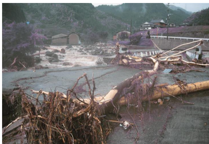
▲ 土砂災害で道路寸断 (平成 24 年 7 月九州北部豪雨・妹川地区持木)
