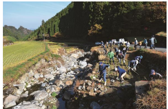
写真2=被災した棚田を復旧するボランティア
