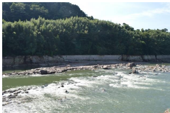
▲ 今夏の九州北部豪雨による夜明ダム損壊により、突如現れた袋野堰の跡 (今年 8 月)
