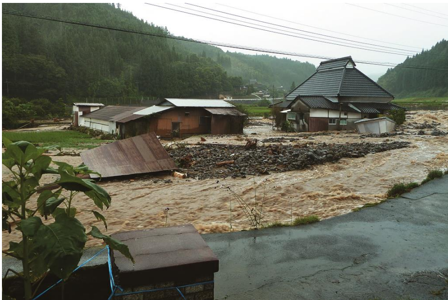
▲ 氾濫した小塩川(平成 24 年 7 月九州北部豪雨・小塩地区女子尾)
